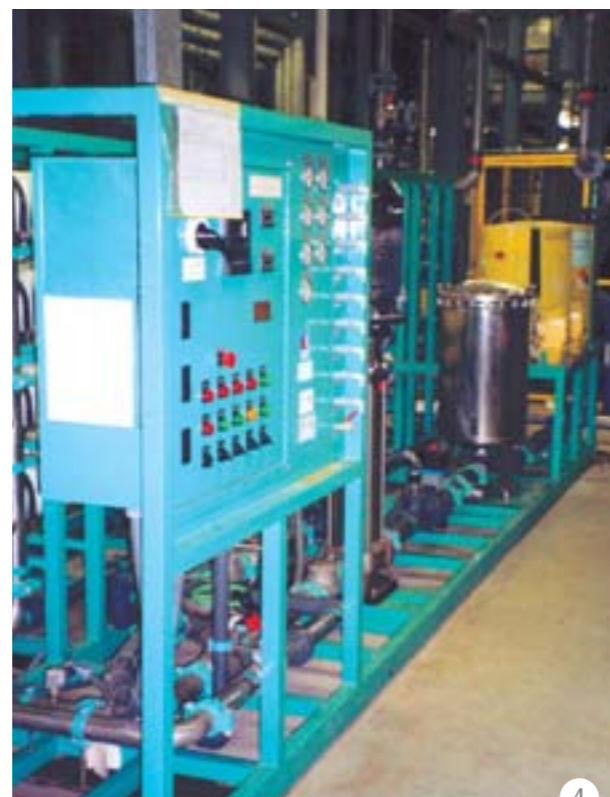
Provincia de Buenos Aires. 3- Potabilización de agua superficial. Hotel Hilton, Iguazú. Pcia. de Misiones. 4- Sistema de tratamiento por Ósmosis Inversa. Planta General Motors. Caudal: 30m 3 /h. Rosario Pcia. de Santa Fé.
