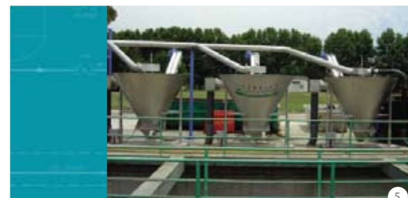
4- Equipos clasificadores/lavadores de arena provenientes de camiones atmosféricos. Establecimiento Sudoeste - AySA. Pcia. de Buenos Aires.
