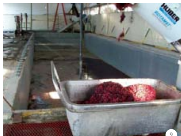
8- Sistema de Aireación para Curtiembre Arlei. Las Toscas. Pcia. de Santa Fé. 9- Pretratamiento de Línea Roja. Matadero y frigorífico de vacunos. Quickfood. Villa Mercedes. Pcia. de San Luis.
