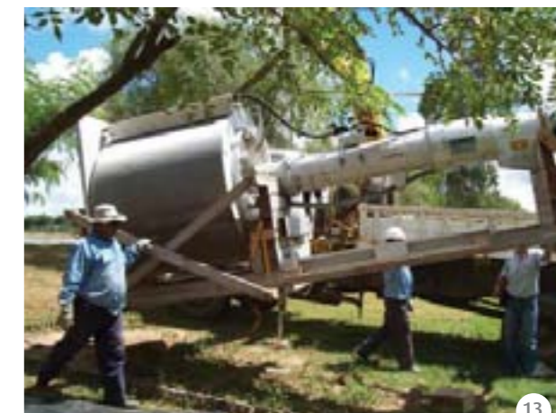
izable Environmental Dynamics Inc. con 42 difusores Minipanel Duplex cada uno. Coteminas S.A., Montes Claros, Minas Gerais, Brasil. 13- Pretratamiento para Parque Industrial. Tamiz de 1800 mm. de diámetro y 1mm. de separación en Santa Cruz de la Sierra. Bolivia.
