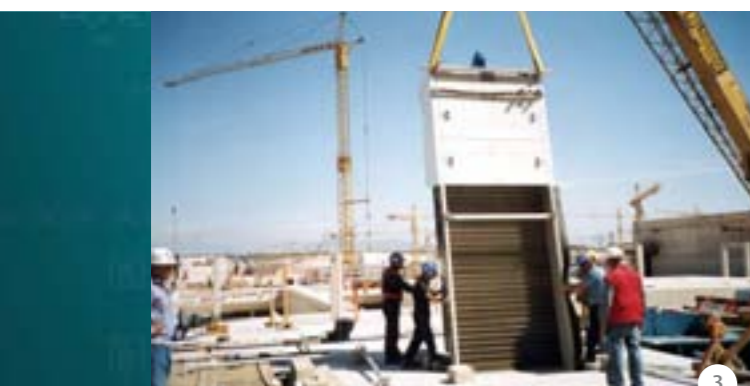
1- Planta depuradora. 3 tamices rotativos Huber Rotamat, 2,6 m de diámetro. Malla de 0,75 mm. Caudal: 7.500 m 3 /h. Bahía Blanca. Pcia. de Buenos Aires.
